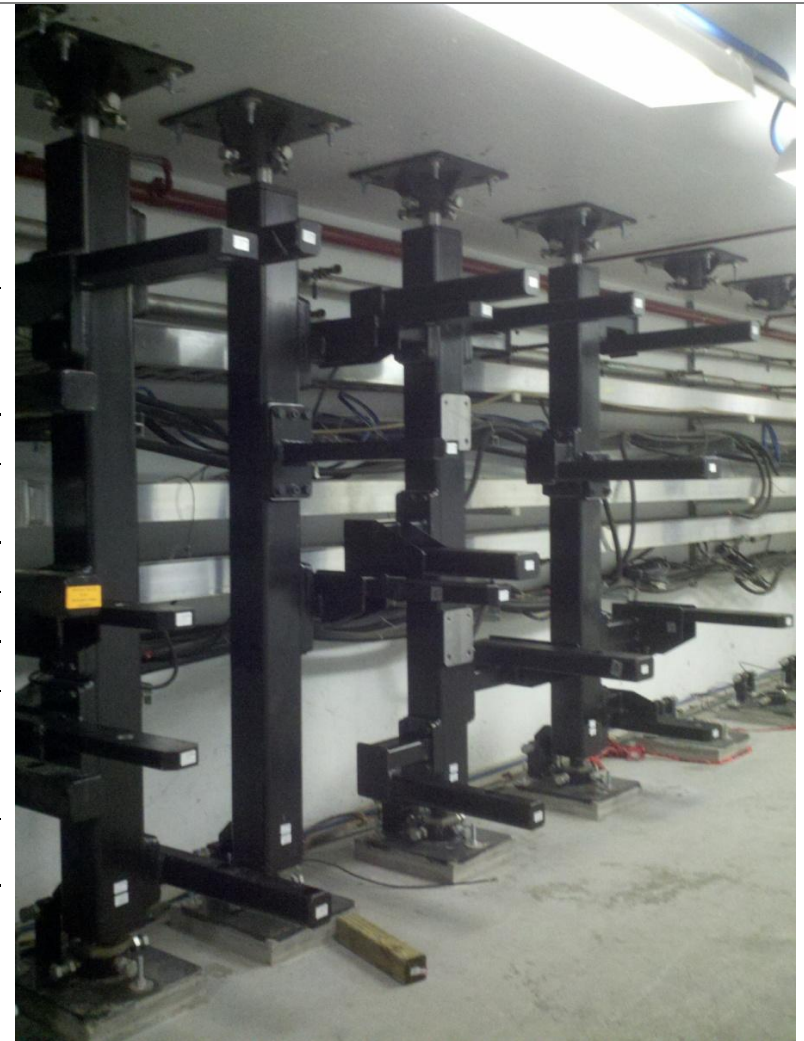
4 ER stands installed
